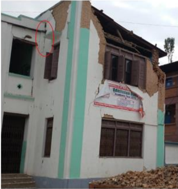
Fig. 2.a: Corner Crack
